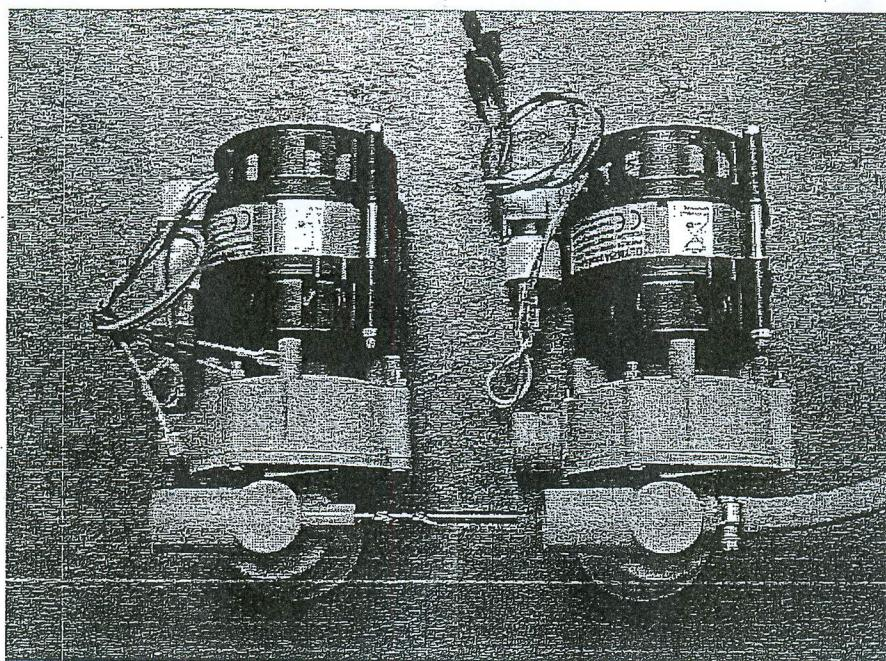
Se in fase di sostituzione della pompa , nel portagomma opposto allo scarico , c'è un tubo inserito , prima di fissare questo alla nuova pompa aprire il foro con una punta da trapano diametro 6 mm .
